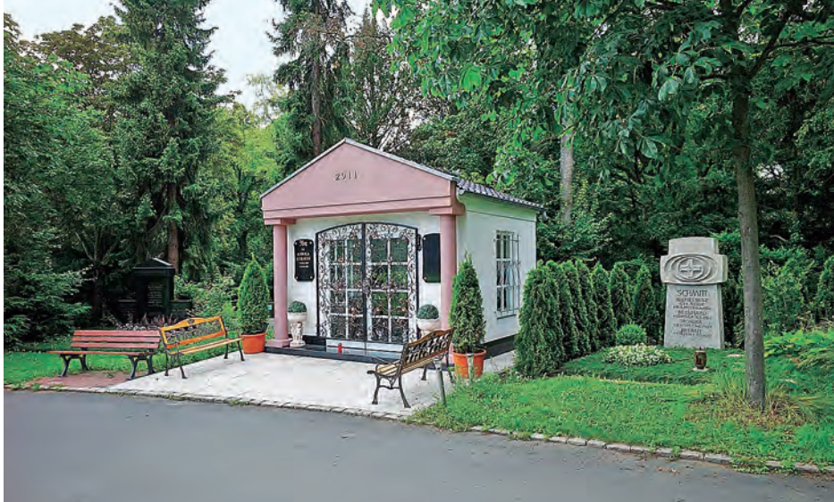
Abb. 4: Neubau eines Mausoleums auf dem Frankfurter Hauptfriedhof Bild: Jürgen Hasse
